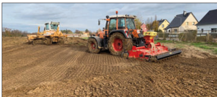
Die Fotos dokumentieren den aktuellen Baustand am 2. November 2022. Fotos: Grünland GmbH
