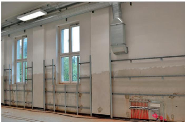
*Blick in die künftige Mehrzweckhalle. Derzeit wird der Prallschutz montiert, auf den Fotos ist die Unterkonstruktion bereits zu sehen. Die Fotos zeigen den Baustand am 12. Mai 2021.*
