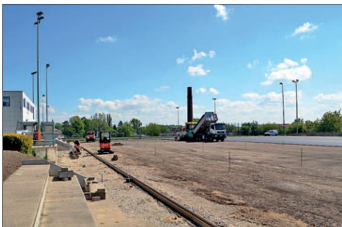
Einbau der Asphalt-schicht und Arbeiten an Wegen und Randbereichen. Fotos: Hönsch
