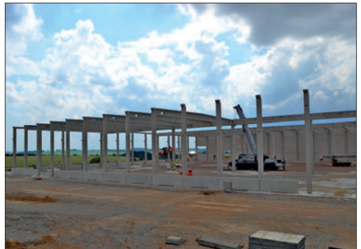
Bauvorhaben im erweiterten Industriegebiet an der A 4, Juni 2018.
