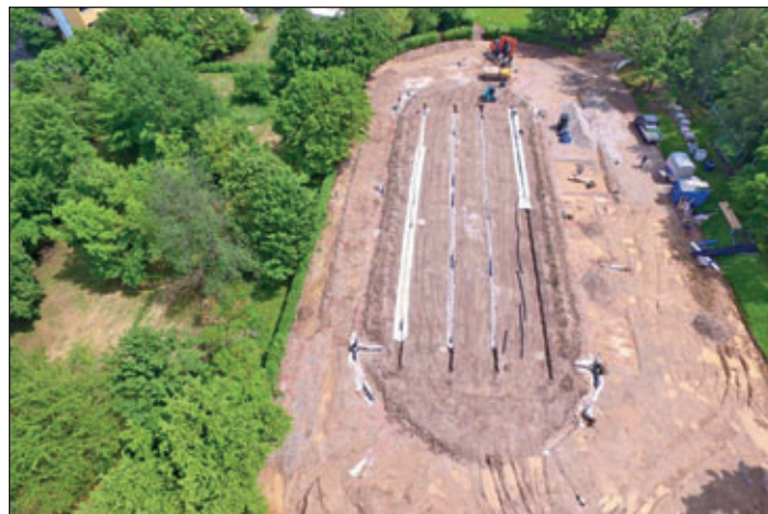
Der Schulsportplatz Friedrich-Engels-Schule während der Drainagearbeiten im August 2021.
