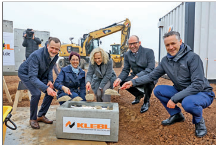
Grundsteinlegung für die Halle 7 im Industriepark Meerane: Dr. Ludwig Fazel, Volkswagen AG, Cathleen Frost, metaWERK AG, Staatssekretärin Ines Fröhlich, Bürgermeister Professor Dr. Lothar Ungerer, Meerane, und Carsten Michaelis, Beigeordneter des Landkreises Zwickau (v.l.n.r.).
