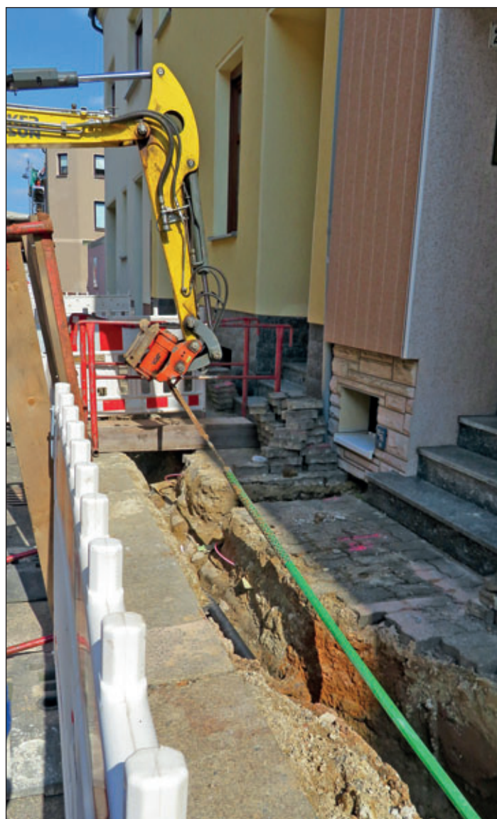
Verlegung der Leerrohre für das Glasfaserkabel in der Martinstraße. Foto: Stadtwerke Meerane
