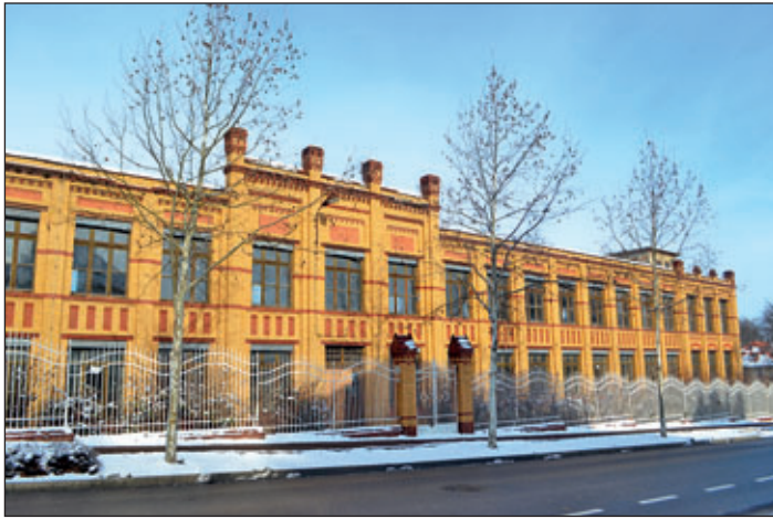
Das historische Fabrikgebäude Franz Louis Quaas/Segeltuch-Industrie AG ist vom Rückbau ausgenommen.
