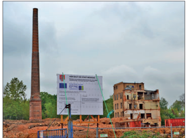
Stand Abbrucharbeiten 4. Mai 2020.
