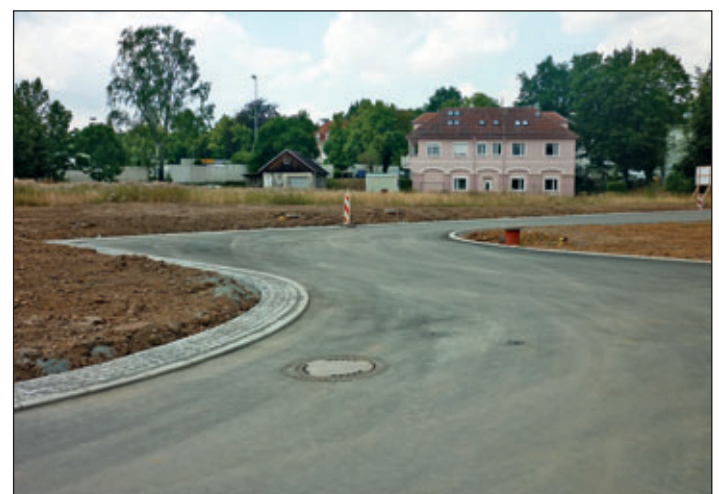
Erschließungsstraße im Baugebiet „An der alten Spinnerei“.
