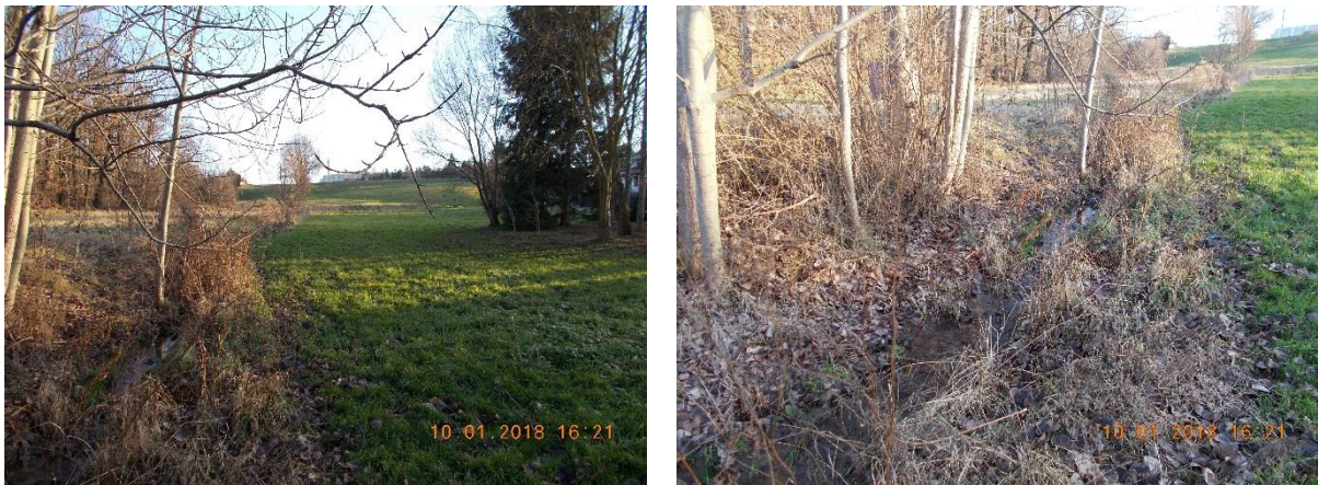
Abb. 4: Zufluss zum Dittrichbach am J.-Wertheim-Weg Meerane
