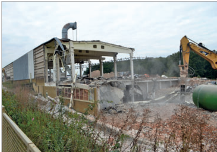
Abbruchgeschehen am 21. September 2021
