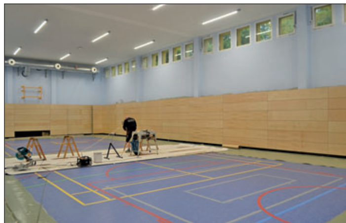
Baustand am 4. Oktober 2021. Der Sportboden ist fertiggestellt, die Montage der Prallwand ist zu großen Teilen erfolgt. Fotos: Hönsch
