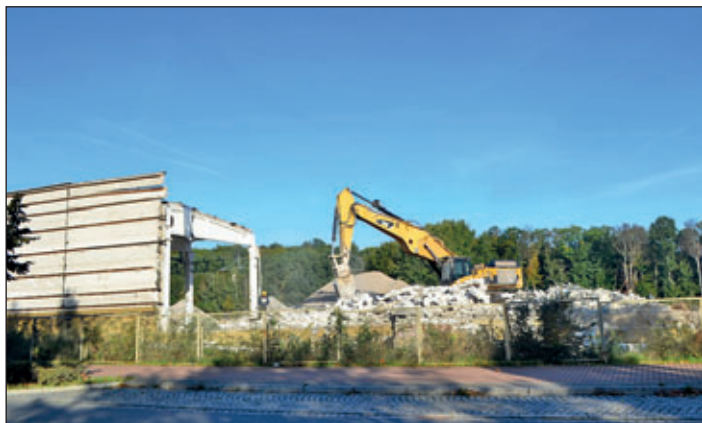
Abbruchgeschehen am 1. Oktober 2021 Fotos: Hönsch
