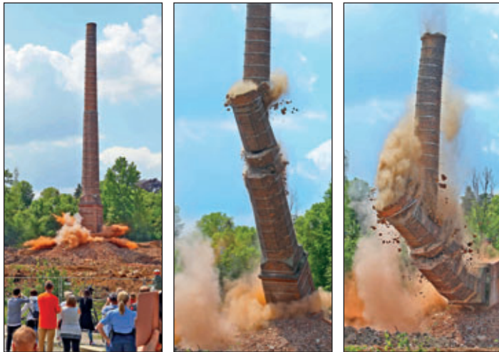
Am 27. Mai 2020 wurde der Schornstein der ehemaligen Kammgarnspinnerei Meerane gesprengt.
